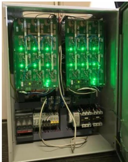
Рис. 2 Вид АКЭС с открытой передней панелью
